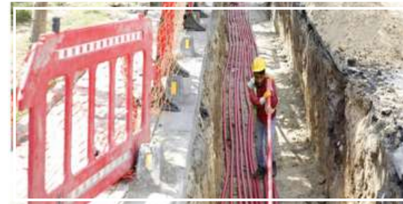
Yeraltı Kablo İmalatı
